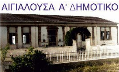
Α' Δημοτικό Σχολείο Αιγιαλούσας
